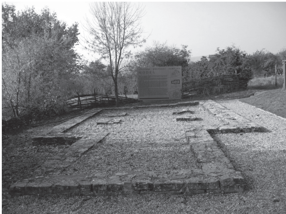
Rekonštrukcia základov kostola (sv. Jána Krstiteľa?) v Modrej pri Velehrade.
